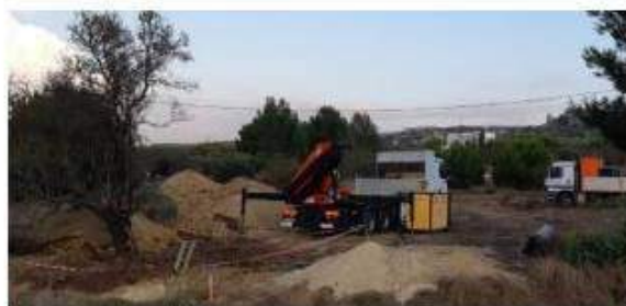
Remblais sur le secteur à protéger
